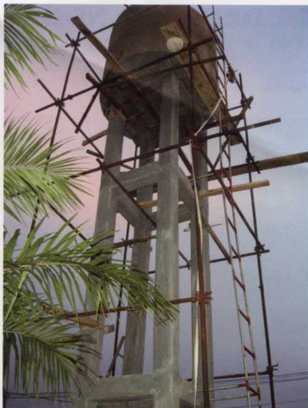
La cisterna in fase di completamento nella parrocchia di Don Donald, nella diocesi di Sokodè (foto dal viaggio di aprile 2007).
